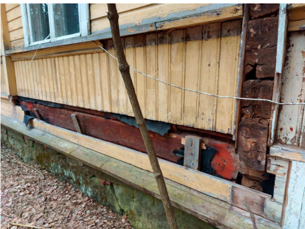
Päärakennuksen hirsiseinä rakenteita kuntotutkimuksen yhteydessä tehtyjen rakenneavauksien jäljiltä. Kivihiilitervapaperia on poistettu seinästä. Kuvat 5/2023.
